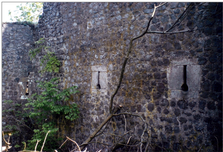
A 16 Schlüsselschießscharten an der nördlichen äußeren Ringmauer der Weidelsburg von außen gesehen – in der Nähe des Ippinghäuser Tores.
